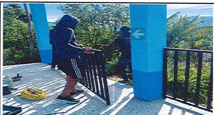
Foto 4: Mejoramiento de barandas de metal
