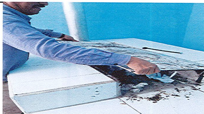
Foto 3: Sustitución de plancha de metal de 3 hornillas.
