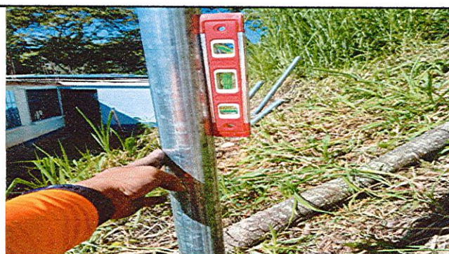
Foto 6: Reparación de muro perimetral de block con tubo hg y malla galvanizada, soleras intermedias y columnas.
