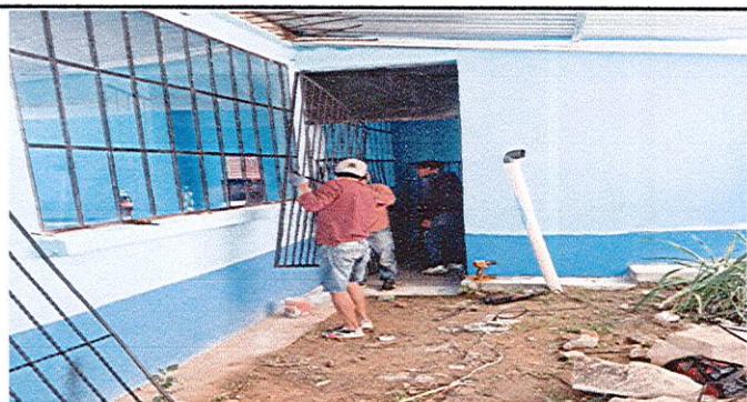
Foto 5: Mejoramiento de balcones de metal en ventana en ambos lados.
