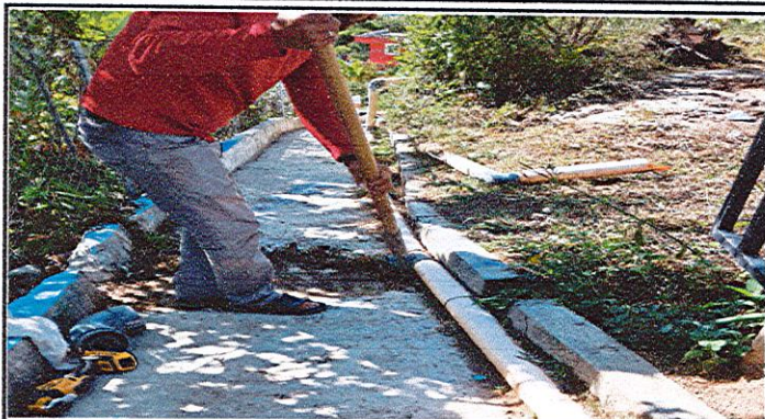
Foto1: Sustitución de tubería PVC línea principal aguas negras
