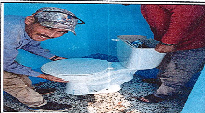
Foto 2: Sustitucion de inodoro.
