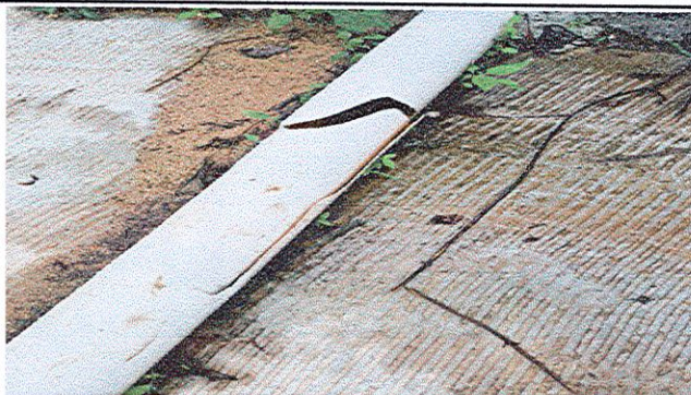
Foto 1: Sustitución de tubería PVC línea principal aguas negras
