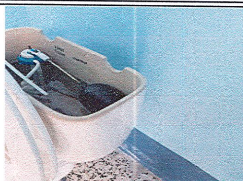
Foto 2: Sustitución de inodoro.
