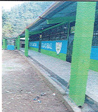
Foto 2: Pintura interna y externa
