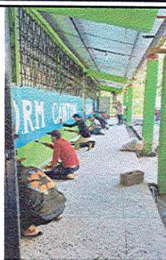
Foto 2: Pintura interna y externa
