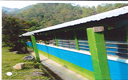
Foto 6: Circulación y canales de la escuela
