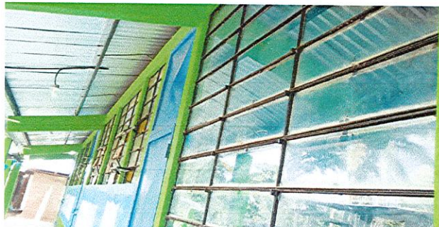
Foto 1: Balcones de estructura metalica
