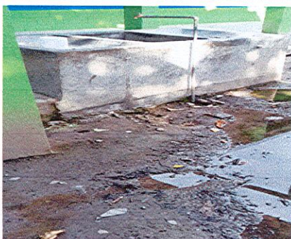
Foto 5: Deposito de agua
