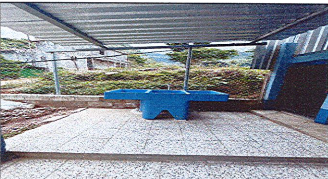
Foto 3: COLOCACIÓN E INSTALACIÓN DE DEPÓSITO DE AGUA (PILA)
