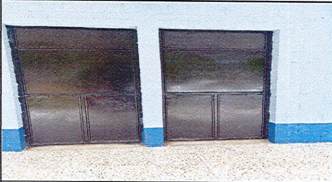
Foto 1: MANTENIMIENTO, LIJADO Y PINTURA DE PUERTAS
