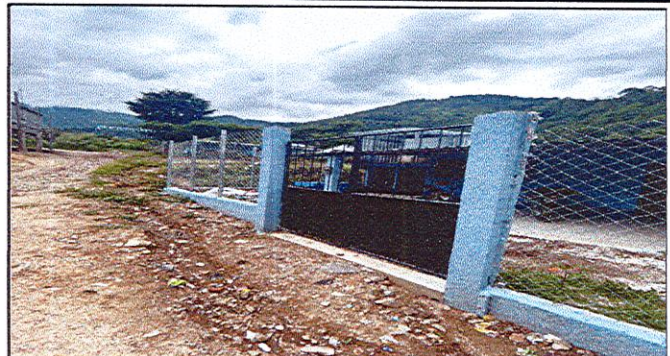
Foto 2: COLOCACIÓN DE PORTÓN DE METAL FINALIZADO
