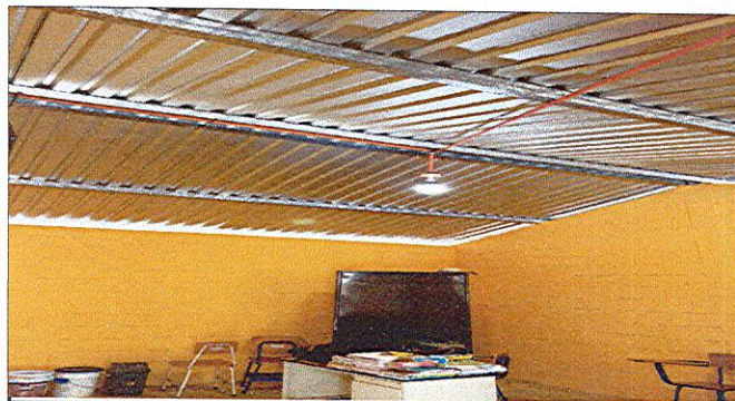
Foto 7: COLOCACIÓN DE ESTRUCTURA DE METAL Y LAMINA TROQUELADA FINALIZADA
