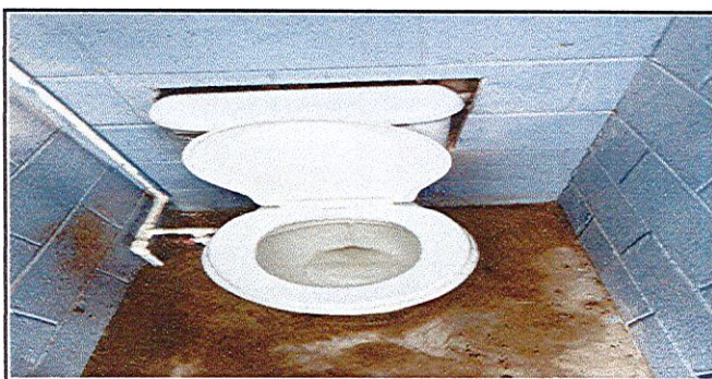
Foto 11: MEJORAMIENTO DE SERVICIOS SANITARIOS
