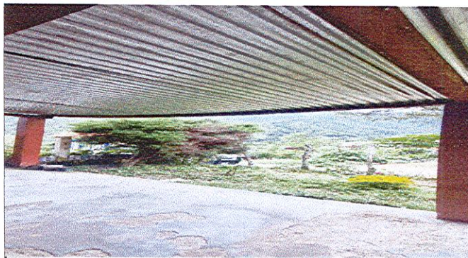
Foto 7: COLOCACION DE LAMINA TROQUELADA
