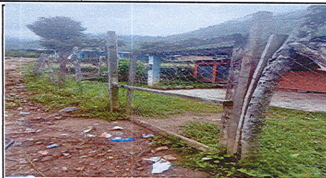
Foto 2: INSTALACIÓN DE PORTÓN
