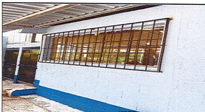
Foto 9: COLOCACIÓN DE BALCÓN FINALIZADO
