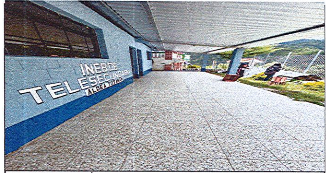
Foto 6: COLOCACIÓN DE PISO DE GRANITO
