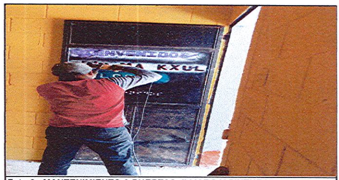
Foto 6: MANTENIMIENTO A PUERTAS (LIJADO Y PINTURA)
