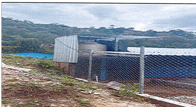
Foto 11: INSTALACIÓN DE DEPÓSITO DE AGUA (TINACO) FINALIZADA
