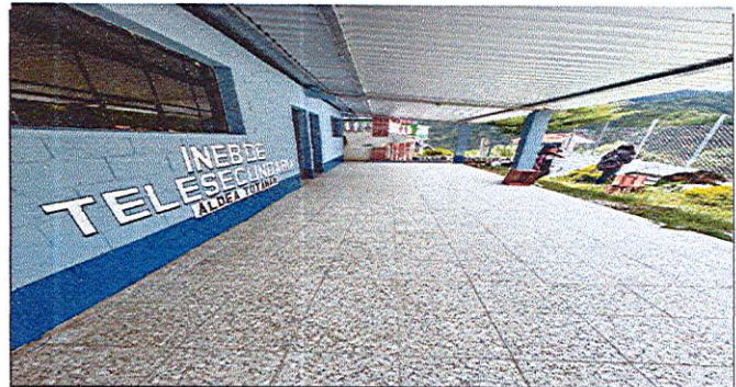
Foto 6: COLOCACIÓN DE PISO DE GRANITO
