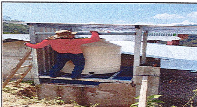
Foto 3: INSTALACIÓN DE DEPÓSITO DE AGUA 1,100 LITROS.
