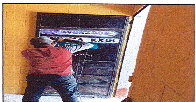
Foto 6: MANTENIMIENTO A PUERTAS (LIJADO Y PINTURA)
