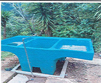
Foto 5: Se mejoraron pilas de almacenamiento de agua
