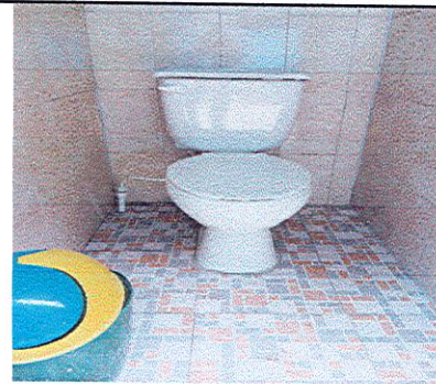
Foto 2: se cambiaron tazas y se pegó azulejos a los baños.
