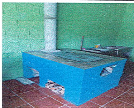
Foto 6: Sustitucion de plancha, pintura, chimenea
