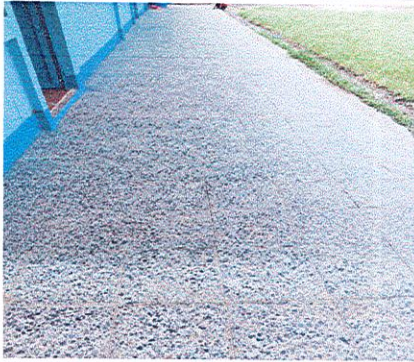
Foto 1: Se colocó piso de granito al corredor del escuela.
