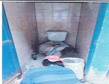
Foto 2: Reemplazando taza sanitaria
