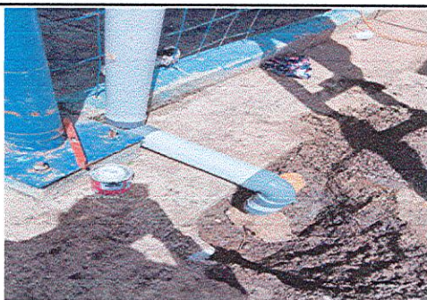
Foto 3: Descripción: se estaban componiendo las bajas de aguas fluviales
