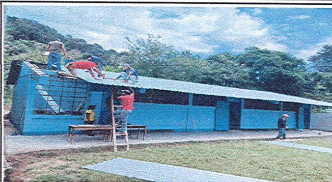
Foto 1: Se Estaba cambiando la lamina del techo de la escuela
