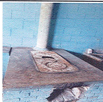
Foto 6: Sustitución de plancha y mejoramiento de cocina.
