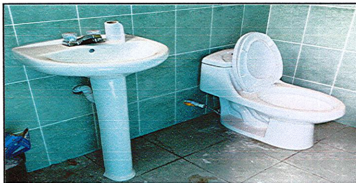
Foto 5: Baños y lavamanos nuevos ya instalados.
