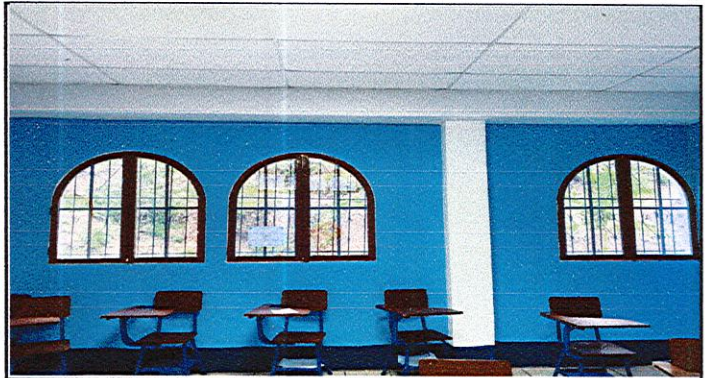
Foto 2: Las ventanas instaladas con accesos a ventilación adecuada.
