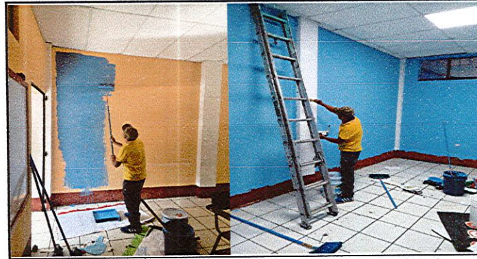
Foto 4: Trabajador pintando las paredes del establecimiento educativo.
