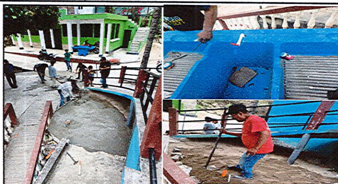
Foto 8: Albañil realizando proceso de instalación de pila de cemento.
