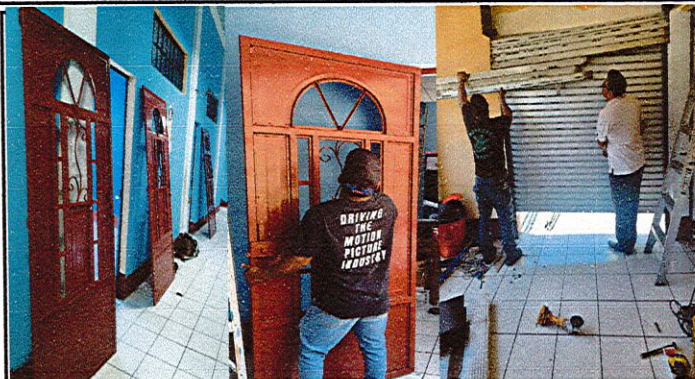
Foto1: Instalando puertas y persiana nueva.
