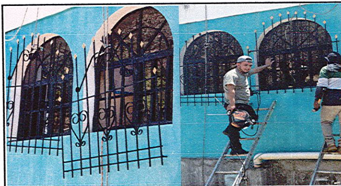
Foto 3: Personal realizando instalación de balcones.
