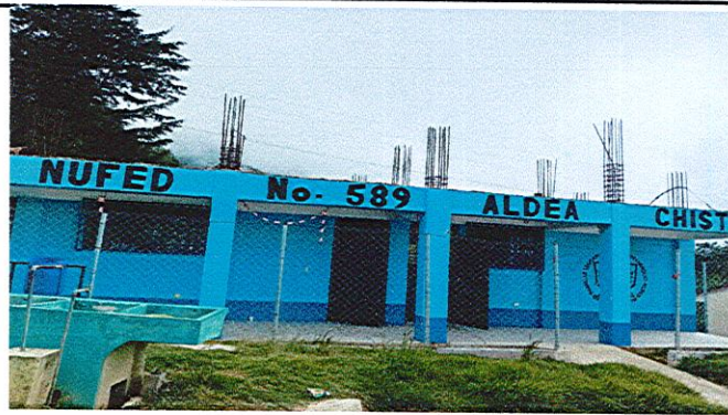
Foto1: Reparación de muro perimetral
