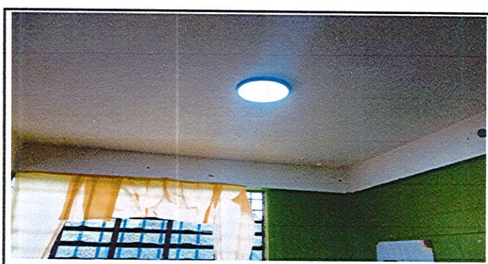
Foto 4: Sustitución de lámparas LED
