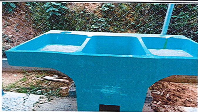
Foto 1: Sustrucción de pila de cemento de dos lavaderos
