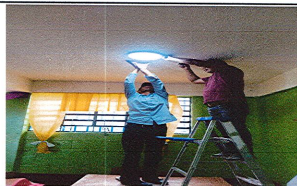
Foto 4: Sustitución de lámparas LED
