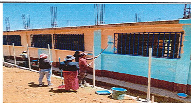
Foto 5: Pintura en interiores y exteriores
