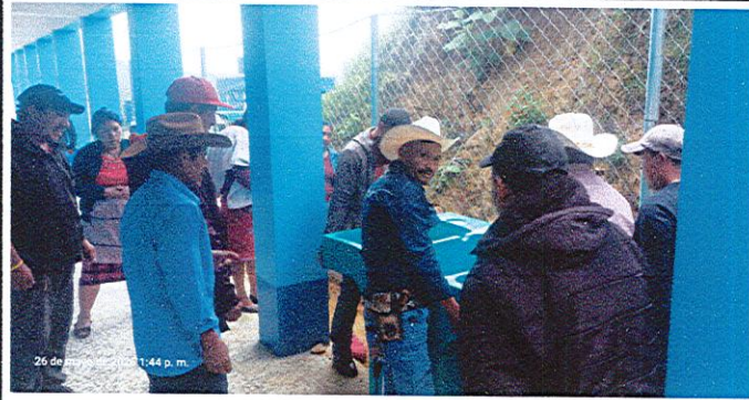
Foto1: Sustrucción de pila de cemento de dos lavaderos
