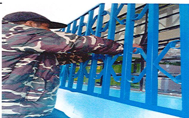
Foto 3: Sustitución de vidrios
