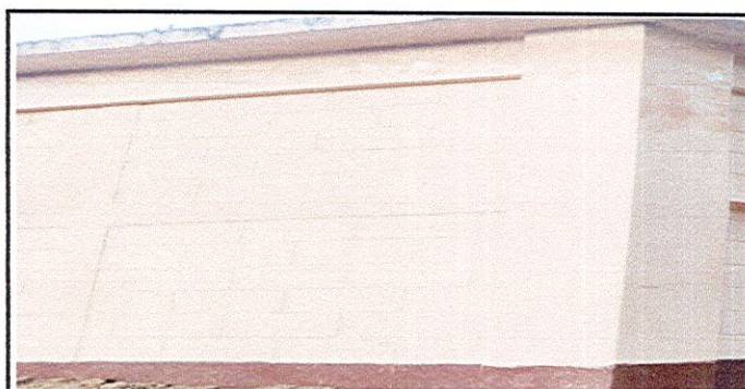
Foto 5: Pintura en interiores y exteriores
