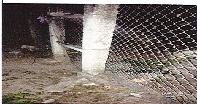
Foto 1: Reparación de muro perimetral
