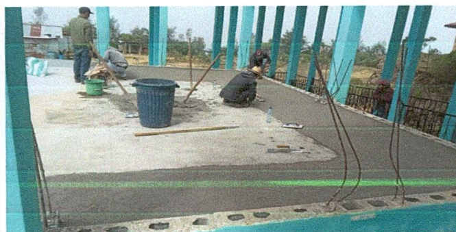
2.1 REPARACION DE PAÑUELOS
