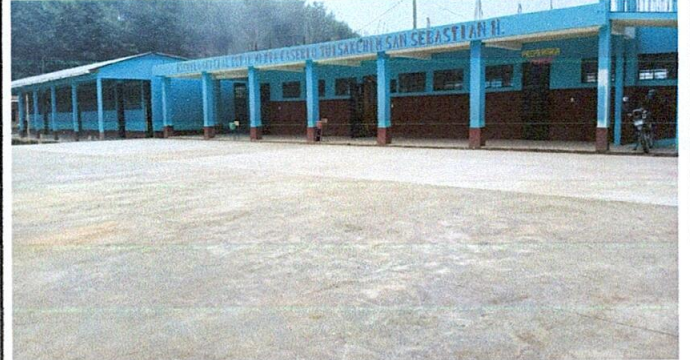
2. SUSTITUCIÓN DE PISO DE TORTA DE CONCRETO
