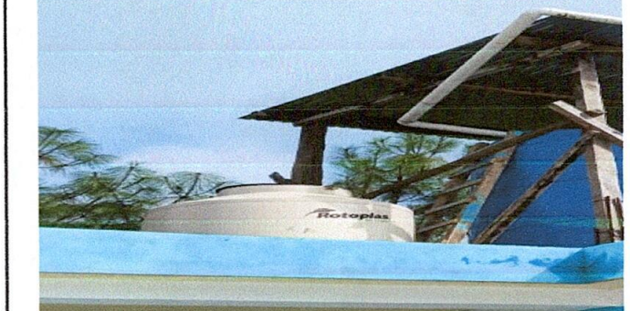
5. SUSTITUCION DE DEPOSITO DE AGUA
