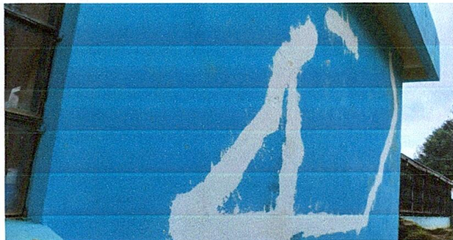
6. SELLADO DE GRIETAS
