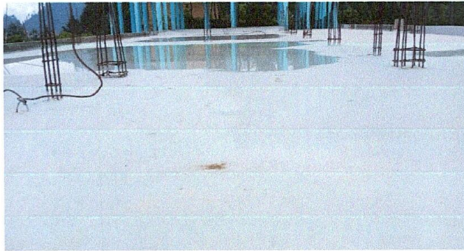
1. IMPERMEABILIZACION DE LOSA
