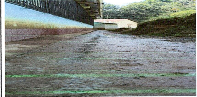
3. REPARACION DE CUNETA DE CONCRETO
