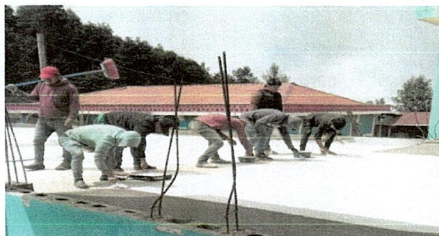
1. IMPERMEABILIZACION DE LOSA
