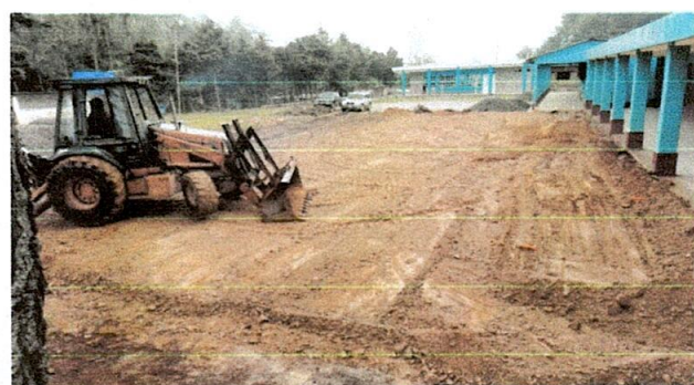
2. SUSTITUCIÓN DE PISO DE TORTA DE CONCRETO
