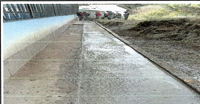
3. REPARACION DE CUNETA DE CONCRETO
