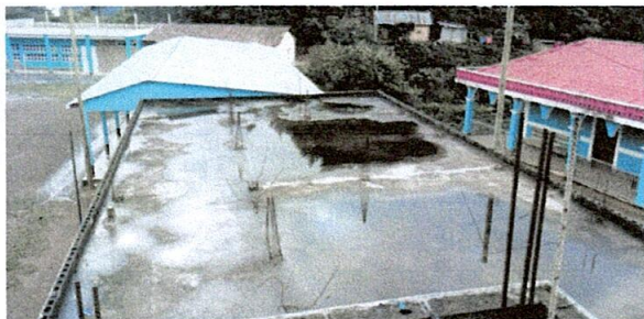
1. IMPERMEABILIZACION DE LOSA
