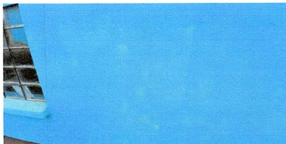
6. SELLADO DE GRIETAS
