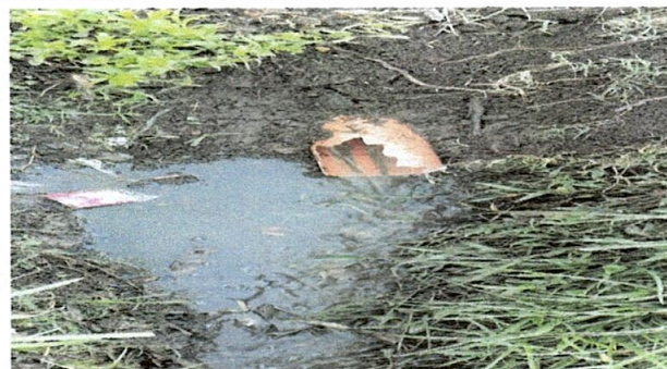
2. REPARACION DE RED DE DRENAJE
