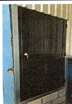
Foto 4: PUERTA DE METAL INSTALADA
