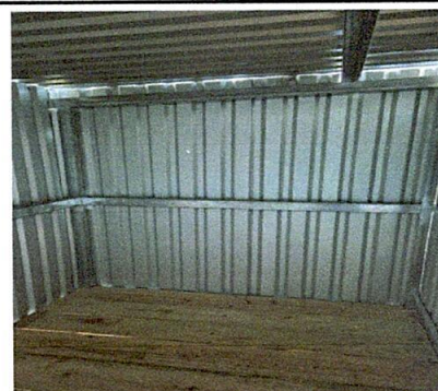
Foto 6: ESTRUCTURA PORTANTE INSTALADO Y TECHO SUSTITUIDO
