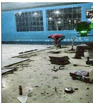
Foto 3: SUSTITUCIÓN DE PISO POR PISO GRANITO (COMPRA Y COLOCACIÓN DE PISO)
