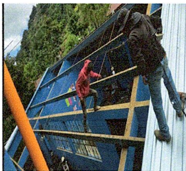
Foto 1: SUSTITUCIÓN DE LÁMINA TROQUELADA (COMPRA Y COLOCACIÓN DE LÁMINA TROQUELADA)
