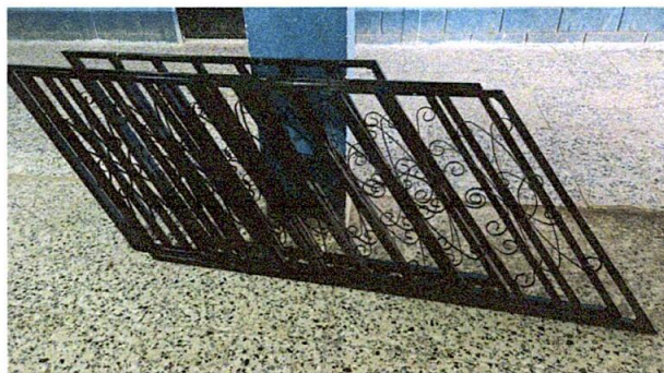
Foto 6: SUSTITUCIÓN DE BARANDAS
