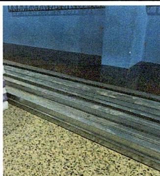
Foto 4: SUSTITUCIÓN DE SOPORTE DE MADERA POR TUBOS DE METAL
