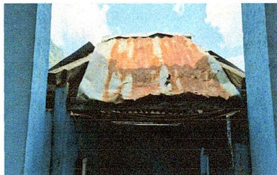
Foto 2: Aquí se realizará sustitución de techo
