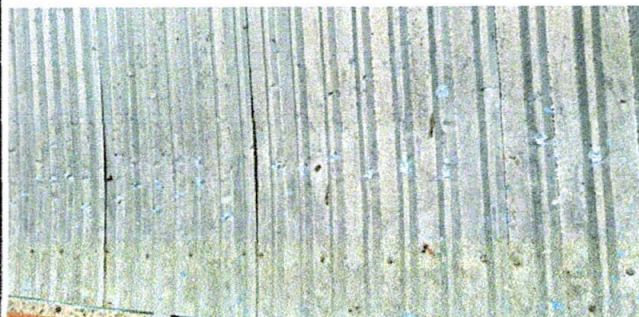
Foto 4: Sustitución de lamina troquila a troquelada.
