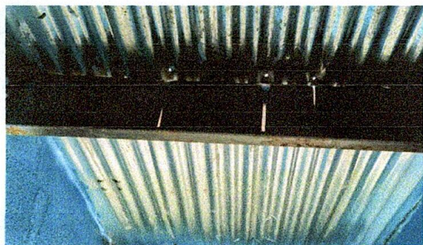
Foto 3: Se realizará sustitución del soporte de metal a metal y de lámina a lámina troquelada.
