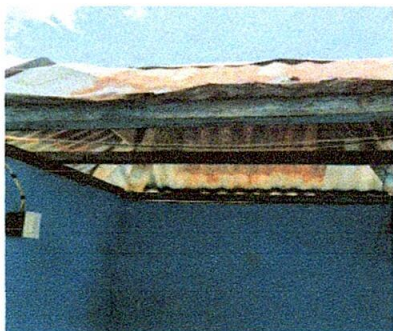
Foto1: Aquí se realizará sustitución de soporte de madera a metal
