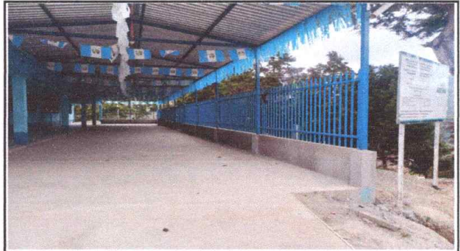
Foto 4: Sustrución de baranda de metal
