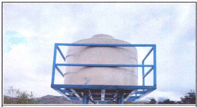
Foto 6: Sustrución de deposito de agua de 2500 LT
