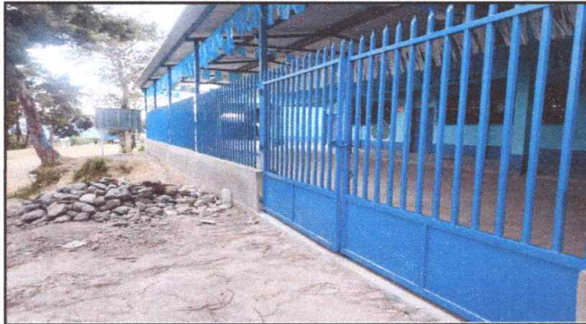
Foto1: Sustrución de chapas (aulas)
