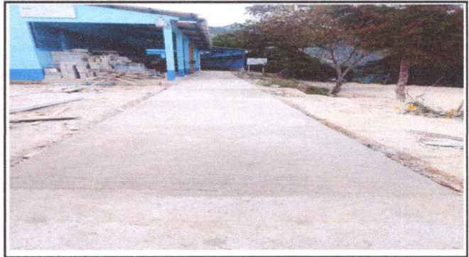
Foto 2: Sustrución de piso de torta de concreto
