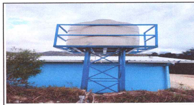
Foto 6: Sustrución de deposito de agua de 2500 LT
