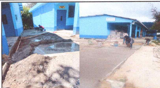
Foto 2: Sustrución de piso de torta de concreto
