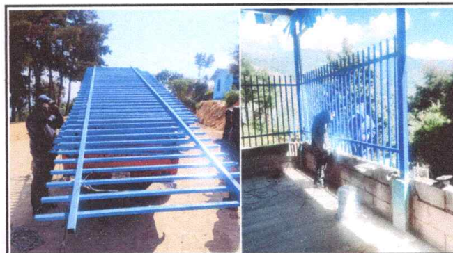
Foto 4: Sustrución de baranda de metal
