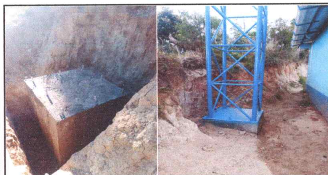
Foto 5: Mejoramiento de base del deposito de agua y su accesorio
