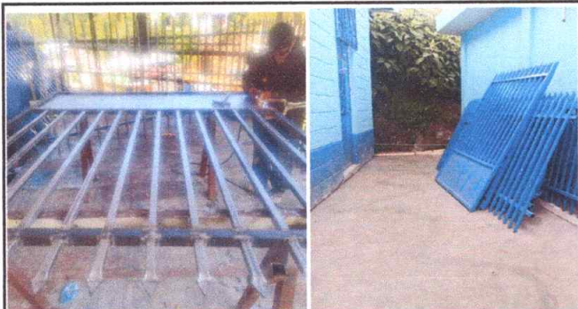
Foto1: Sustrución de chapas (aulas) Cambio por sustrución de porton
