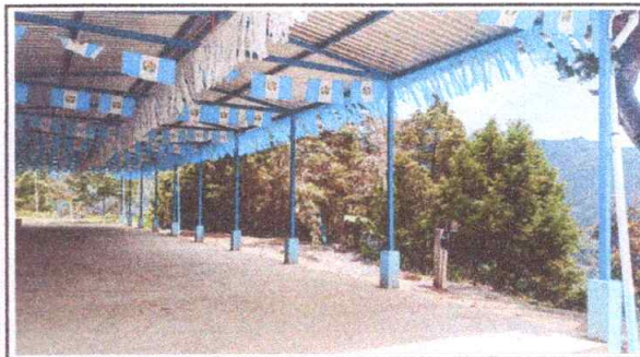
Foto 4: Sustitución de baranda de metal
