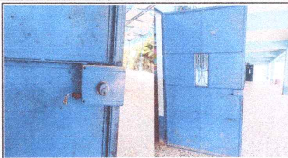
Foto 1: Sustitución de chapas (aulas)
