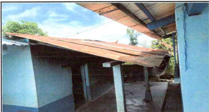
Foto1: Sustrucion de lámina por lamina troquelada aluzinc
