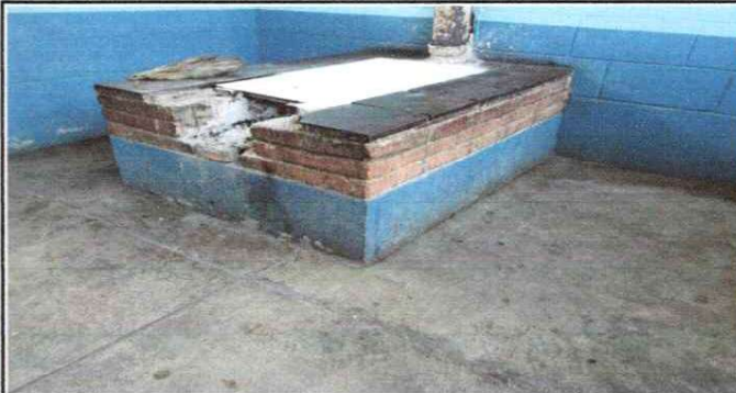
Foto 4: Sustrucion de estufa rural completa
