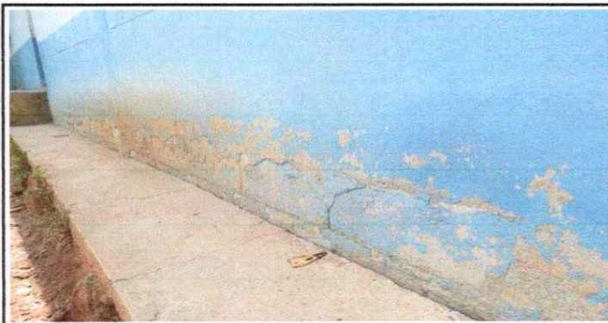
Foto 6: Reparacion de repello y cernido de paredes
