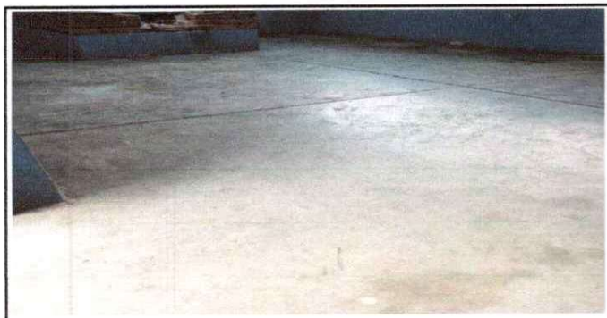
Foto 5: Sustrucion de piso de cemento por piso granito
