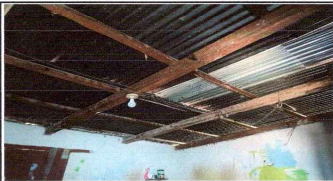
Foto 2: Sustrucion de estructura de soporte
