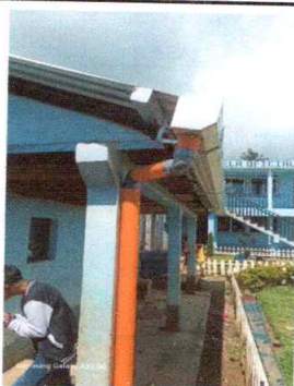
Foto 5: Mejoramiento de canal de metal y bajada de agua lluvia pvc 3"
