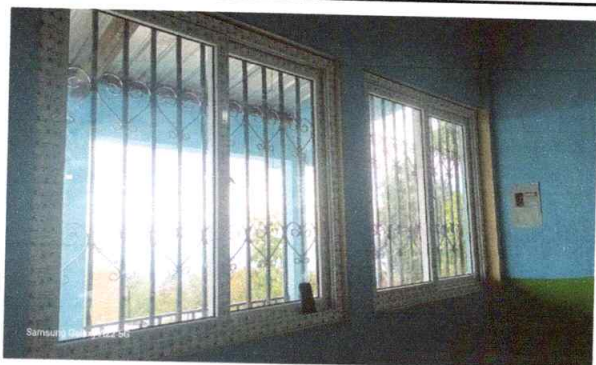
Foto 3: Sustitucion de Ventanas de metal por pvc mas vidrio
