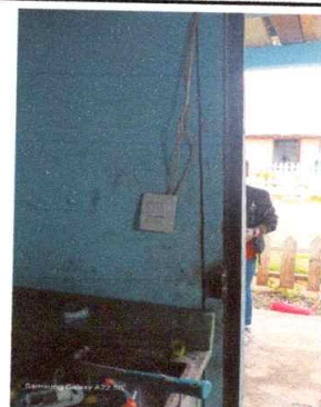
Foto 10: Sustrucción de interruptores dobles y simples
