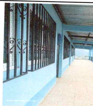
Foto 4: Mejoramiento de balcones en aulas
