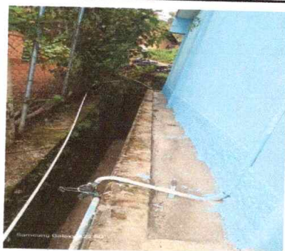
Foto 15: Reparación de repello por cernido de concreto
