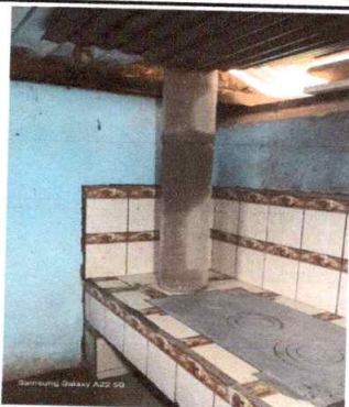
Foto 13: Sustitución de chimenea de metal por concreto
