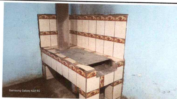
Foto 12: Sustrucción de plancha de metal de 3 ornillos
