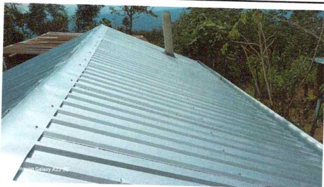
Foto1: Cubierta de lámina
