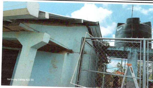
Foto 2: Estructura de techo
