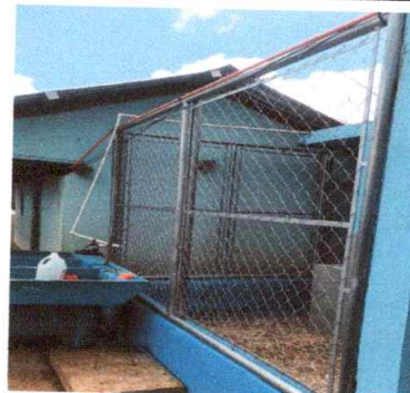
Foto 8: Reparacion de tubo hg y malla galvanizada en multichorro
