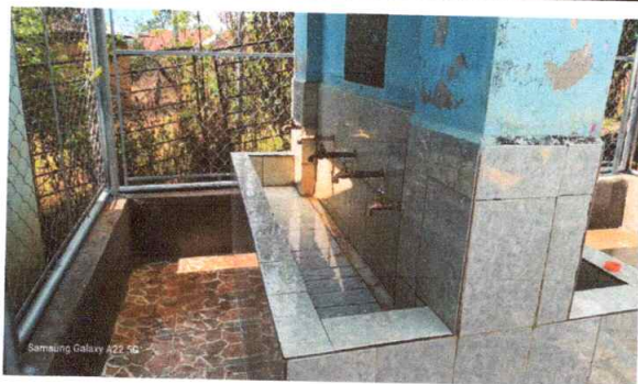
Foto 7: Sustrucción de llave de chorro
