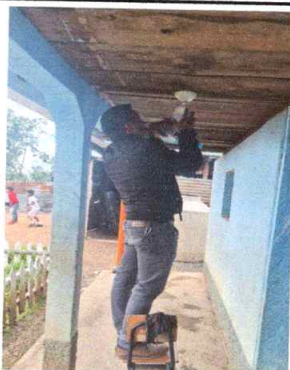
Foto 9: Sustrucción de focos ahorradores
