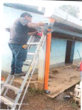
Foto 5: Mejoramiento de canal de metal y bajada de agua lluvia pvc 3"
