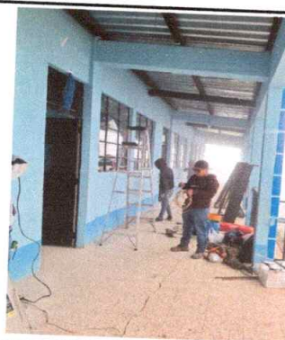
Foto 4: Mejoramiento de balcones en aulas
