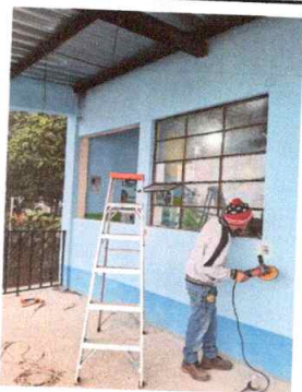
Foto 3: Sustitucion de Ventanas de metal por pvc mas vidrio
