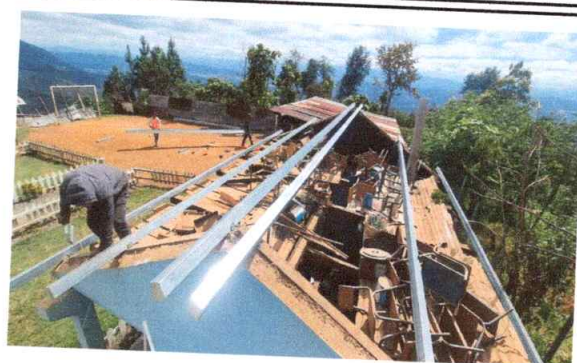
Foto 2: Estructura de techo
