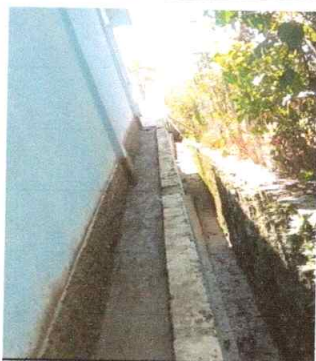
Foto 15: Reparación de repello por cernido de concreto
