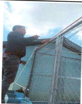
Foto 11: Reparación de Cableado eléctrico y mejoramiento ducto eléctrico mas accesorios
