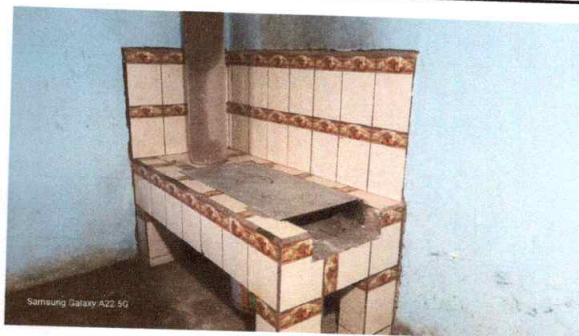
Foto 12: Sustitución de plancha de metal de 3 ornillos
