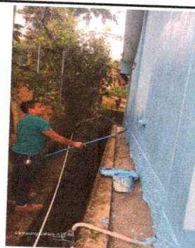
Foto 6: Pintura en muros exteriores, paredes del edificio escolar.
