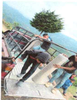
Foto 13: Sustitución de chimenea de metal por concreto
