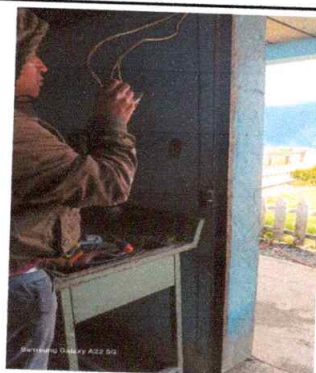
Foto 10: Sustitución de interruptores dobles y simples
