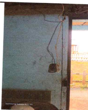
Foto 10: Sustrucción de interruptores dobles y simples
