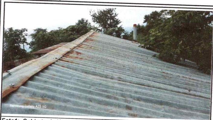
Foto 1: Cubierta de lámina
