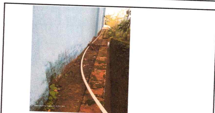
Foto 6: Pintura en muros exteriores, paredes del edificio escolar.
