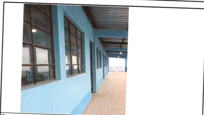
Foto 4: Mejoramiento de balcones en aulas
