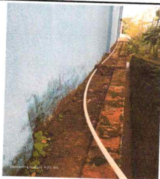
Foto 15: Reparación de repello por cernido de concreto
