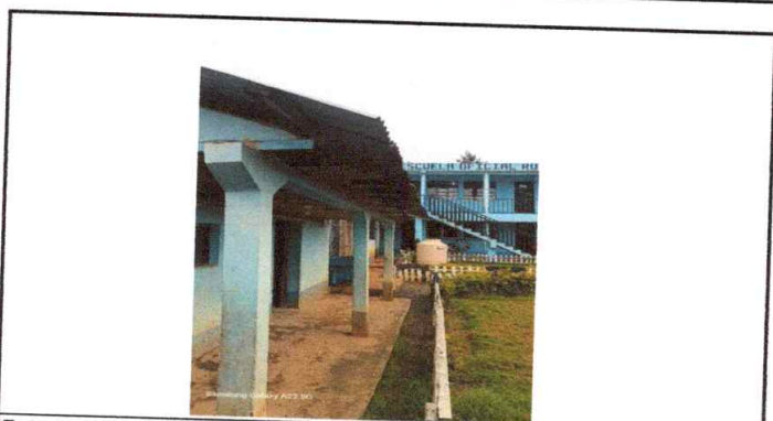
Foto 5: Mejoramiento de canal de metal y bajada de agua lluvia pvc 3"
