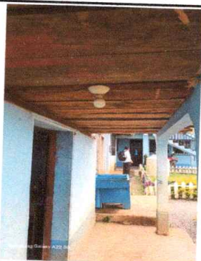
Foto 9: Sustrucion de focos ahorradores
