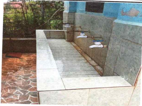
Foto 7: Sustrucción de llave de chorro
