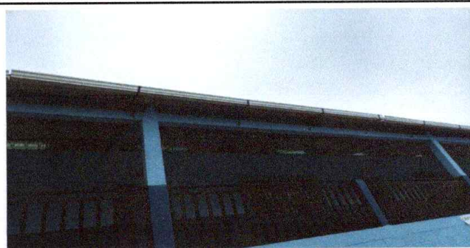
Foto 6 : Sustrucción de canales de pvc y bajadas fluviales
