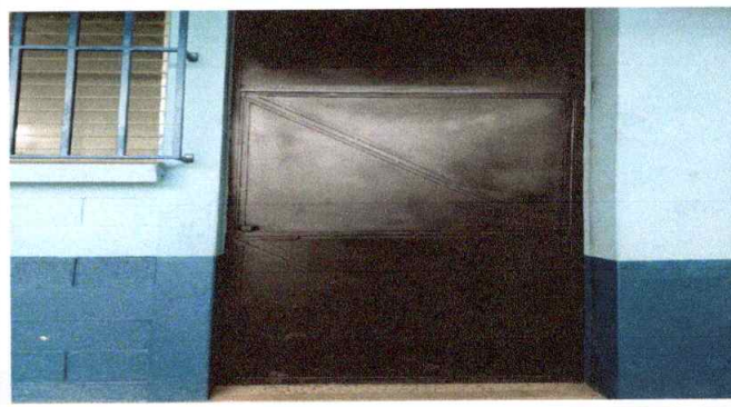
Foto 2: Mantenimiento de puertas de metal
