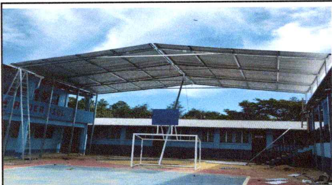
Foto 3: Instalación de lámina troquelada aluzinc
