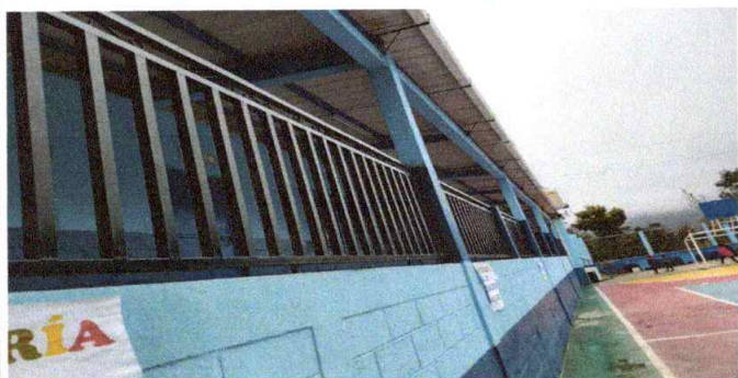
Foto 5 : Mantenimiento de barandas de metal
