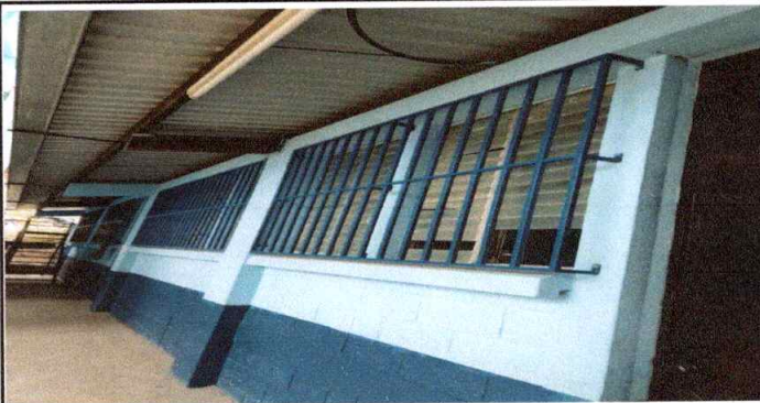
Foto 1: Sustrucción de balcones
