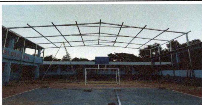
Foto 3: Instalación de soporte del techo
