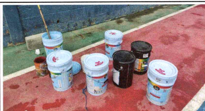
Foto 4: Preparación de pintura para pintar las paredes de la escuela
