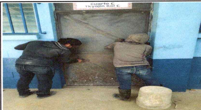
Foto 2: realización del lijado de la puerta de metal
