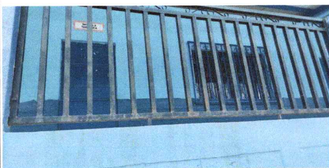
Foto 5 : Realización del lijado de las barandas
