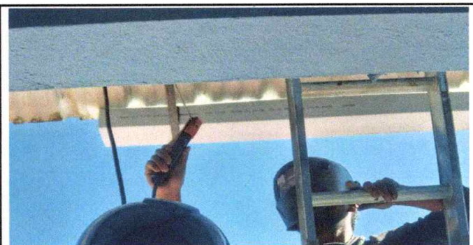
Foto 6: colocación de canales de pvc.
