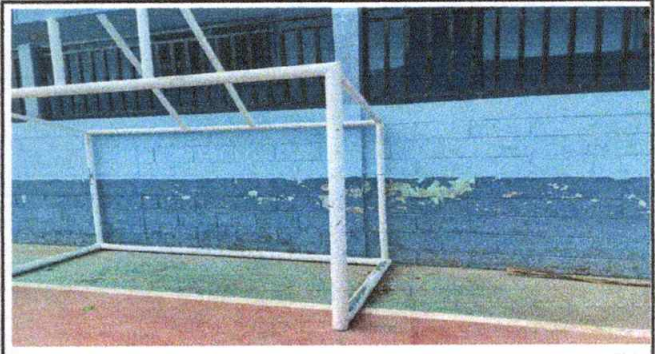
Foto 8: Pintura en muros exteriores e interiores
