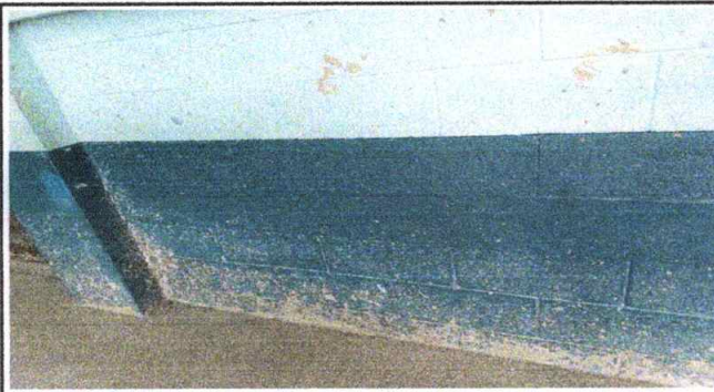
Foto 7: Pintura en muros exteriores e interiores
