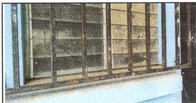
Foto 5: Sustitución de balcones de metal
