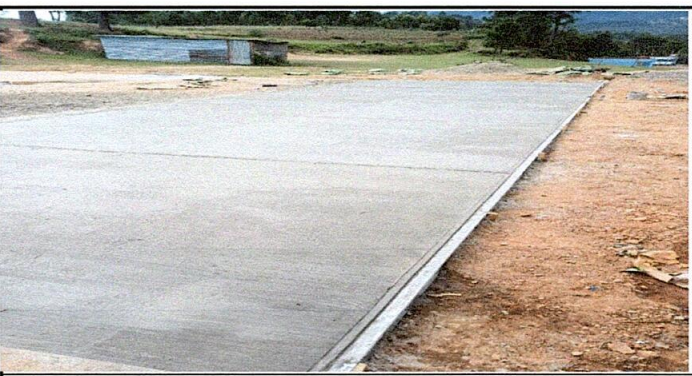
Foto 6: Sustitución de piso de torta de concreto
