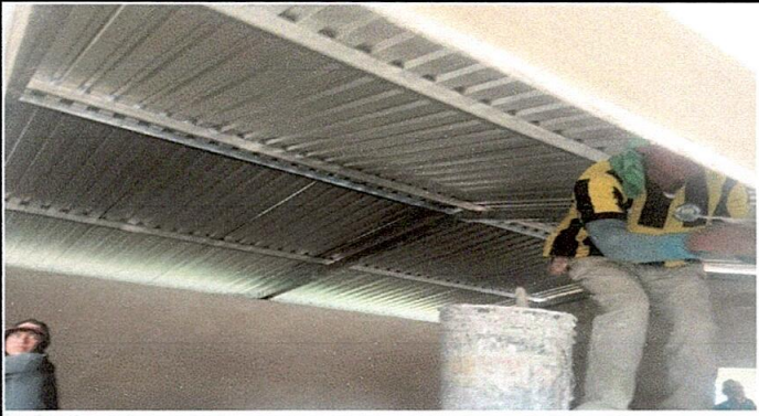
Foto. 7 Sustitucion de fijación
