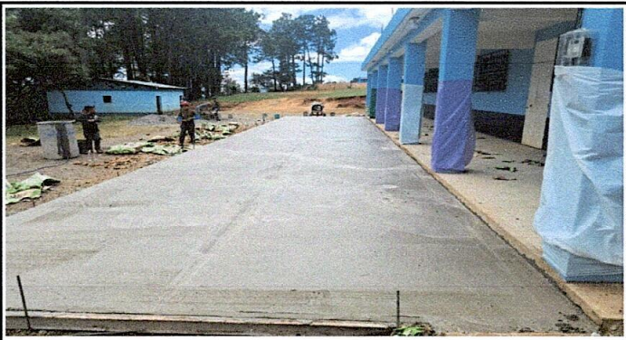
Foto 4: Sustitución de piso de torta de concreto
