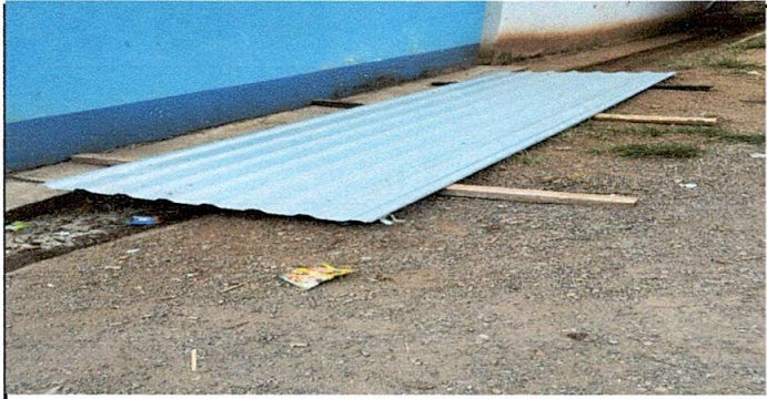
Foto1: Sustitución de lámina, por lámina troquelada aluzinc calibre 24
