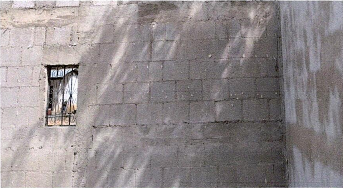
Foto. 10 Dustitucion de de estructuras de metal de ventana
