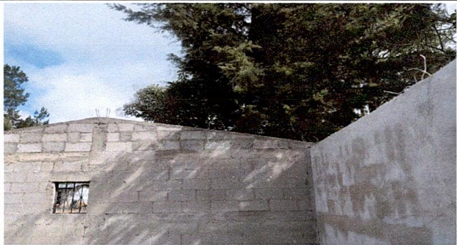
Foto 5: Repello en muro
