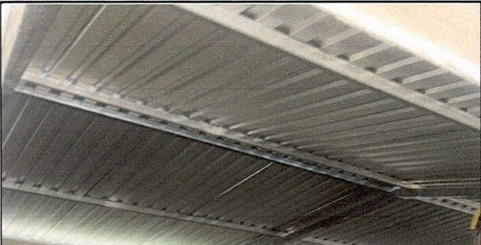
Foto. 12 sustitucion de fijación
