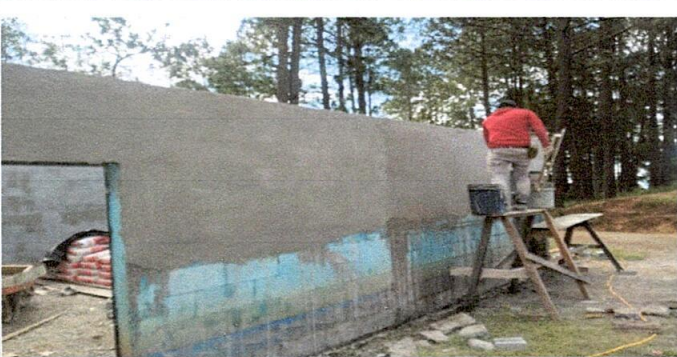
Foto. 9 Repello en muro
