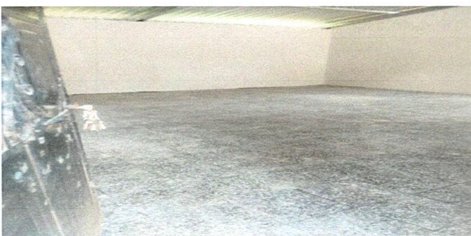
FOTO 11 Sustitucion de piso de ganito
