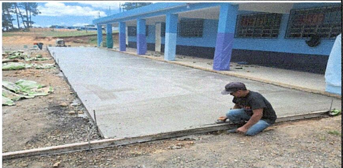
Foto 6: Sustitución de piso de torta de concreto
