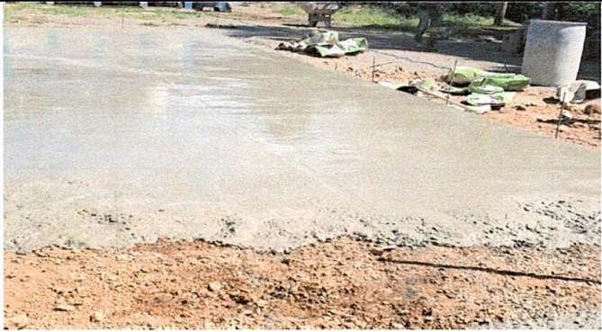
Foto . 7 Sustitución de piso de torta de concreto
