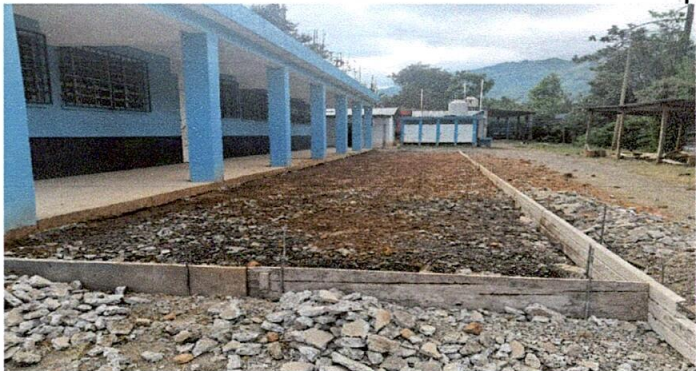
Foto 4: Sustitución de piso de torta de concreto
