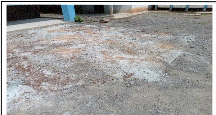
Foto 4: Sustitución de piso de torta de concreto
