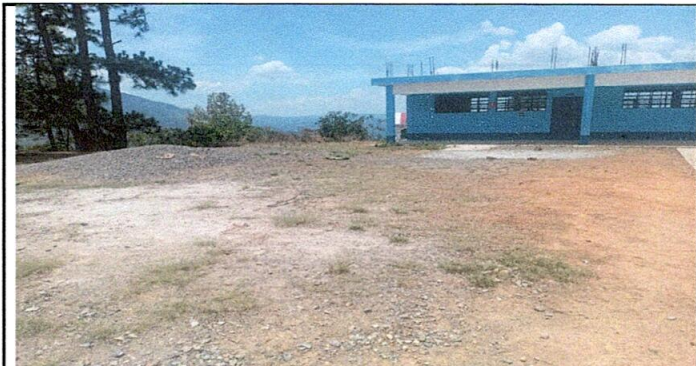
Foto 6: Sustitución de piso de torta de concreto
