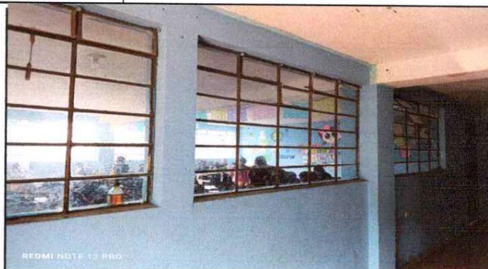
SUSTITUCION DE BALCONES
