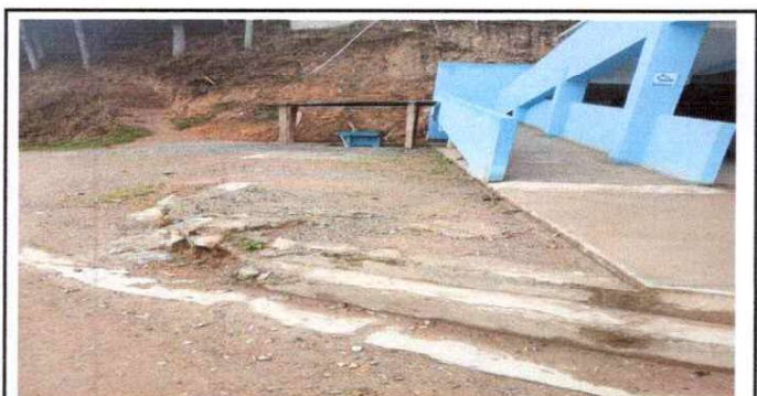
MEJORAMIENTO DE LOSA DE PATIO
