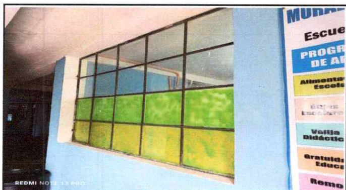
SUSTITUCIN DE VENTANAS
