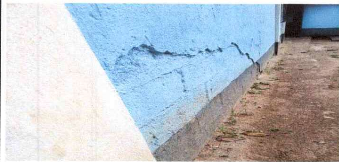
APLICACIÓN DE REPELLO EN PAREDES
