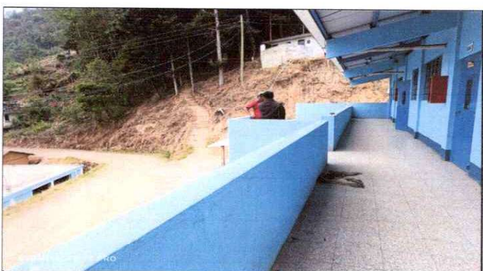
COLOCACIÓN DE BARANDAS DE METAL
