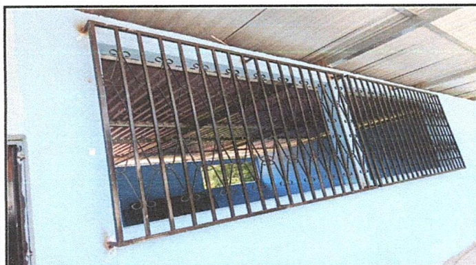
Foto 3: Mejoramiento de balcones
