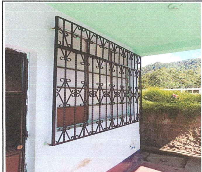
Foto 3: Mantenimiento de balcones
