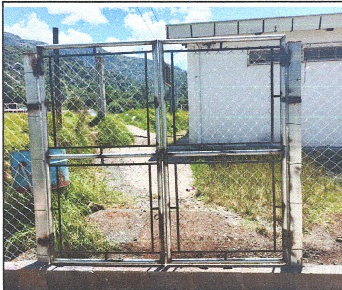
Foto 1: Instalación de portones
