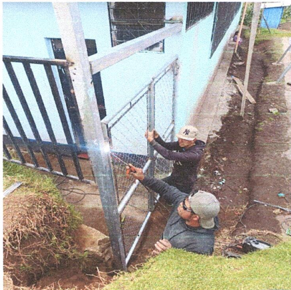
Foto1: Instalación de portones
