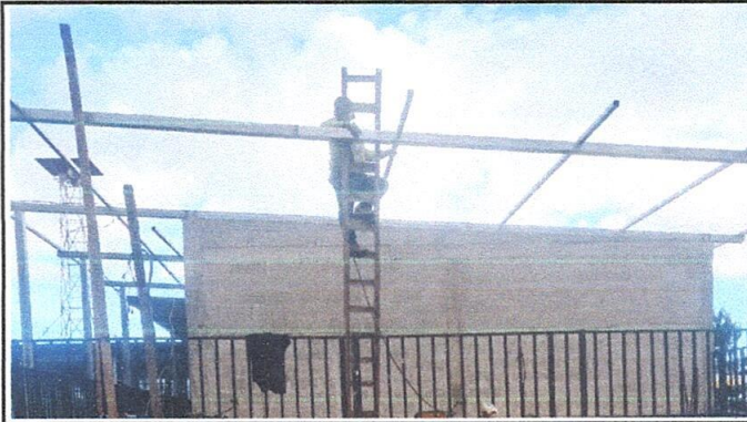
Foto 2: Mejoramiento de techo
