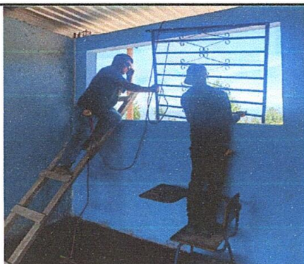
Foto 3: Mejoramiento de balcones
