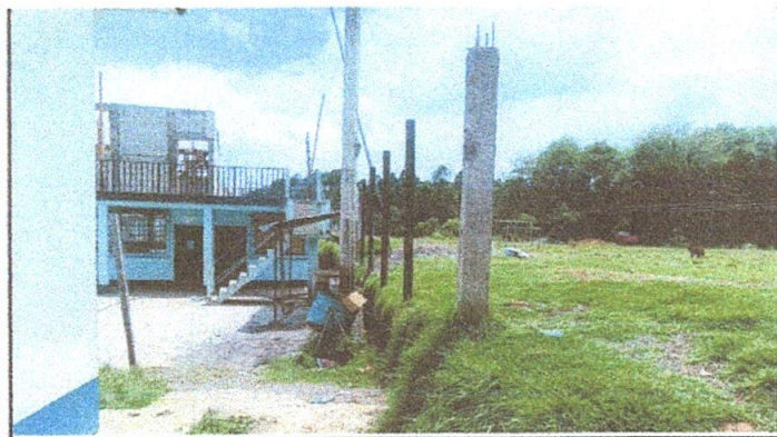
Foto 3: Mejoramiento de muro perimetral con malla y tubo HG
