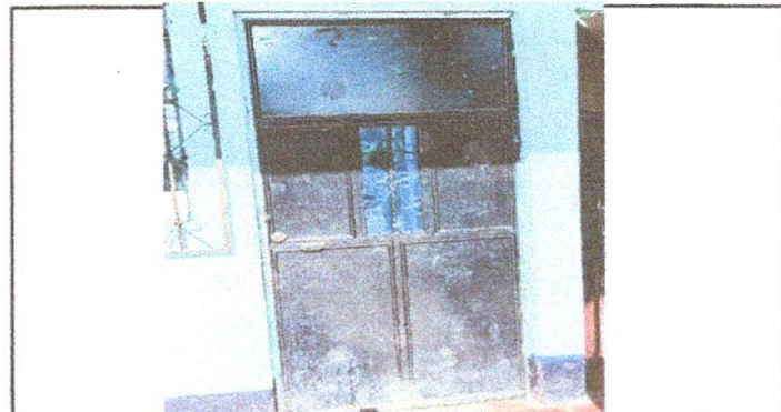
Foto 6: Sustitución de puerta
