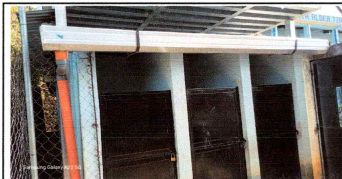
Foto 7: Mejoramiento del canal de metal y bajada de agua pluvial
