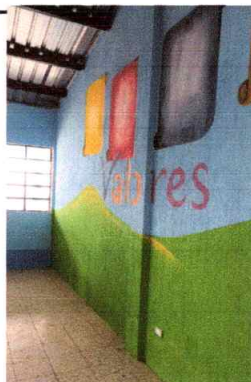
Foto 9: pintura en muros interiores (aulas)
