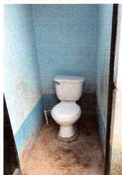
Foto 10: Sustitución de inodoro
