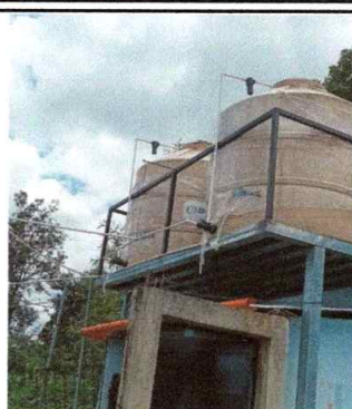
Foto 14: Sustitución de depósito de agua y tubería de pvc
