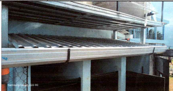
Foto1: Cubierta de lámina y estructura de techo de madera por metal para servicios sanitarios
