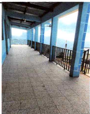
Foto 11: Mantenimiento a barandas de metal
