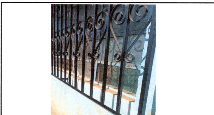
Foto 6: Sustitución de vidrios de ventanas en bodega y dirección
