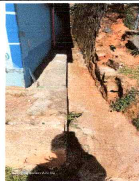
Foto 8: Reparación de cuneta de concreto
