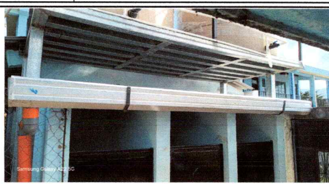
Foto 2: Mejoramiento con base de metal para tanque de almacenamiento de agua
