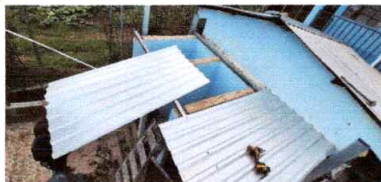
Foto1: Cubierta de lámina y estructura de techo de madera por metal para servicios sanitarios
