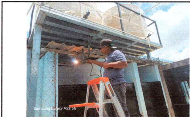
Foto 7: Mejoramiento del canal de metal y bajada de agua pluvial
