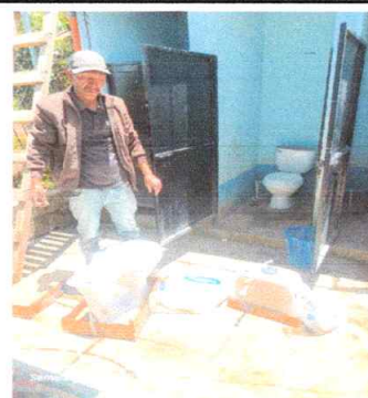
Foto 10: Sustitución de inodoro
