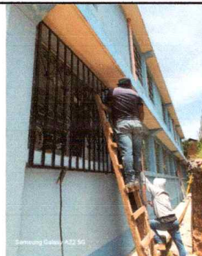
Foto 4: Sustitución de ventanas de aluminio por pvc más vidrio y mejoramiento de balcones de metal para aulas del primer piso del edificio escolar.
