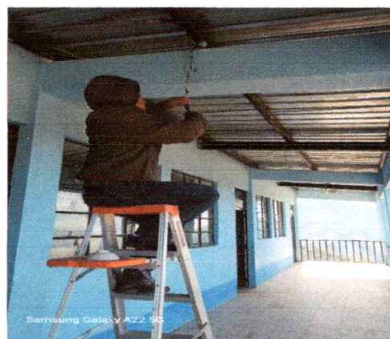
Foto 12: Sustitución de focos y plafoneras
