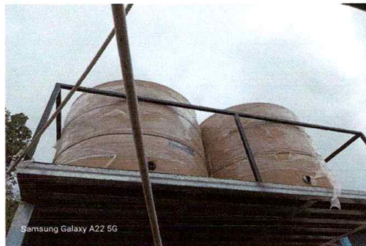
Foto 14: Sustitución de depósito de agua y tubería de pvc
