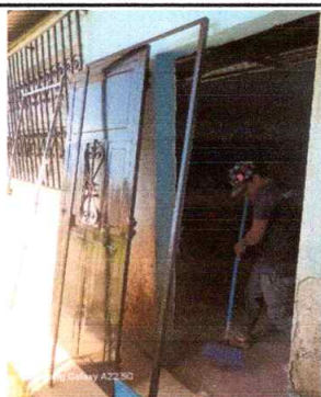
Foto 3: Sustitución Puerta de metal para bodega
