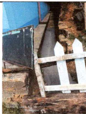
Foto 8: Reparación de cuneta de concreto
