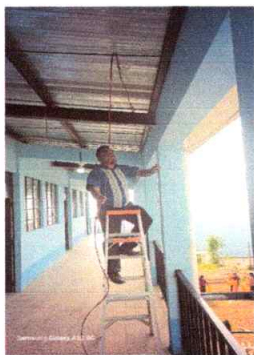
Foto 13: Reparación del cableado eléctrico
