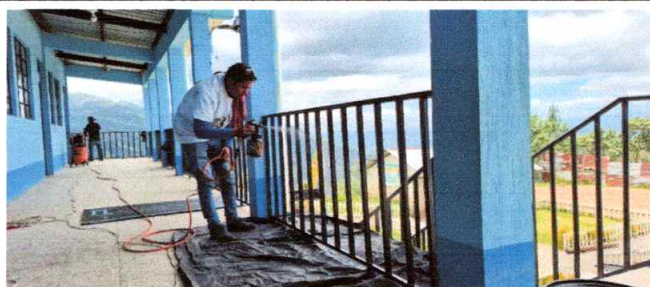
Foto 11: Mantenimiento a barandas de metal
