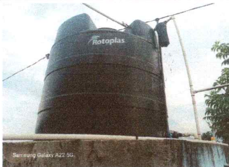
Foto 14: Sustitución de depósito de agua y tubería de pvc
