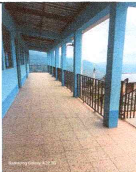
Foto 11: Mantenimiento a barandas de metal
