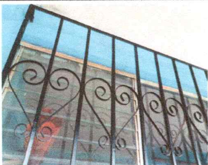
Foto 5: Mantenimiento a marcos de aluminio
