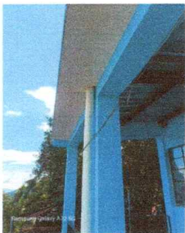
Foto 13: Reparación del cableado eléctrico
