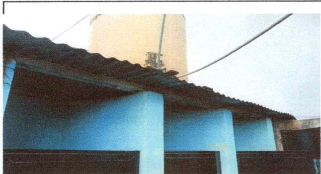
Foto 1: Cubierta de lámina y estructura de techo de madera por metal para servicios sanitarios
