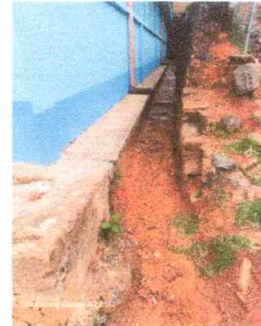
Foto 8: Reparación de cuneta de concreto
