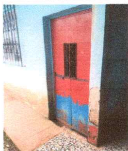
Foto 3: Sustitución Puerta de metal para bodega
