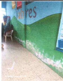
Foto 9: pintura en muros interiores (aulas)
