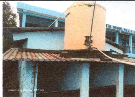
Foto 2: Mejoramiento con base de metal para tanque de almacenamiento de agua
