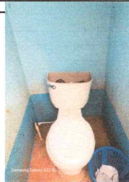
Foto 10: Sustitución de inodoro
