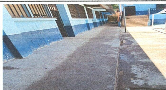
Foto 2: Sustrución de piso de concreto ya finalizado
