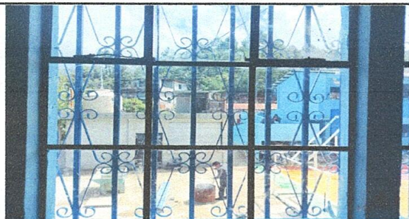
Foto 7: vidrios colocados en las ventanales
