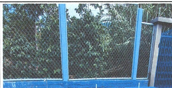
Foto 5: Sustrución de malla galvanizada
