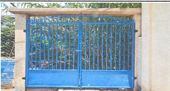
Foto 1: Sustrución de Portón de la entrada principal
