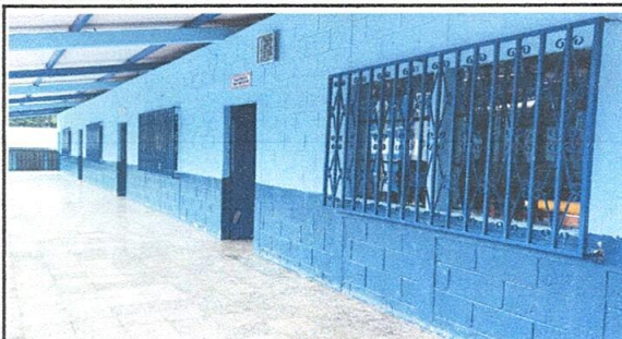
Foto 8: pinturas ya aplicadas en las paredes
