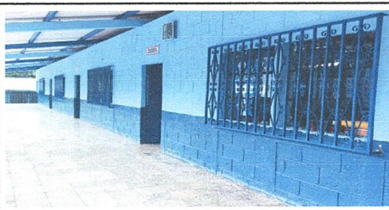
Foto 6: Sustrución de balcones de metal
