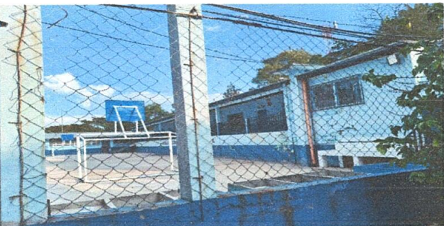
Foto 5: Sustitución de malla galvanizada
