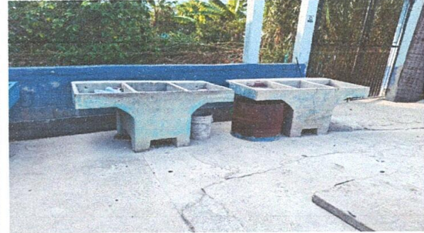
Foto 4: Sustitución de pilas de concreto
