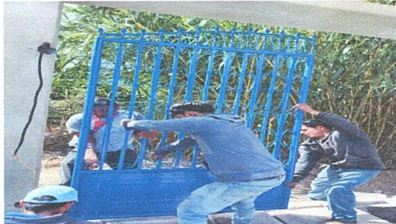
Foto1: Sustitución de Portón
