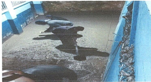
Foto 2: Sustitución de piso de concreto
