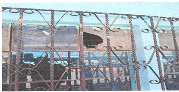
Foto 6: Sustitución de balcones de metal
