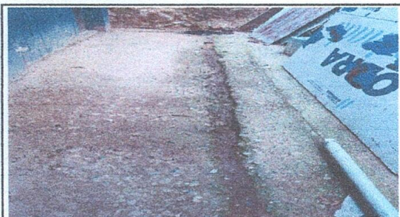
Foto 5: Reparación de torta de concreto
