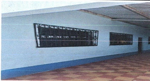
Foto 5: Mantenimiento de balcones
