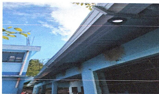
Foto 4: Instalación de canales y bajadas de agua.
