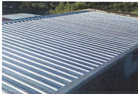
Foto1: Sustitución de lámina nueva,
