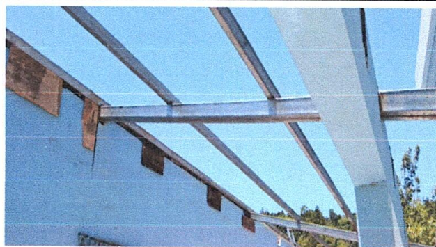
Foto 2: Sustitución de estructura nueva.
